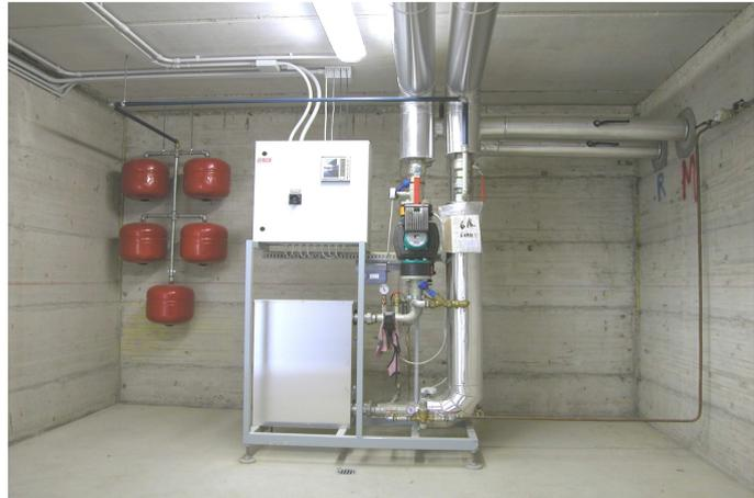
Fig. 2 : Sottostazione di scambio termico
