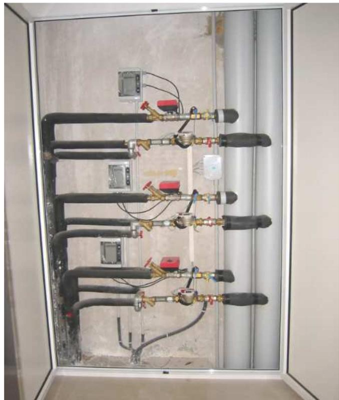
Fig. 3 : Centraline autonome d'utenza
