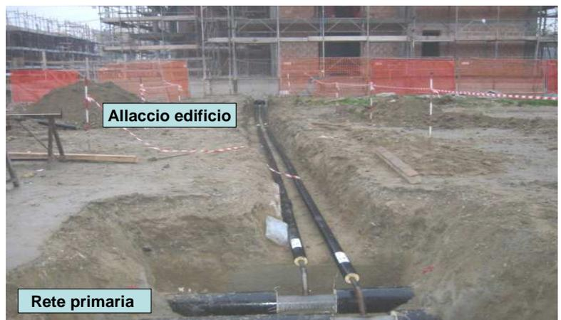
Fig. 1 : Rete di teleriscaldamento
