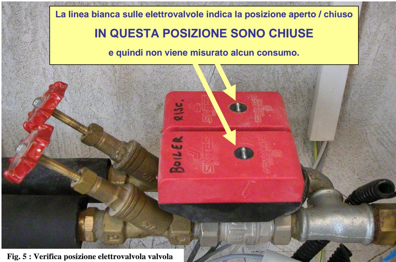
Fig. 5 : Verifica posizione elettrovalvola valvola
